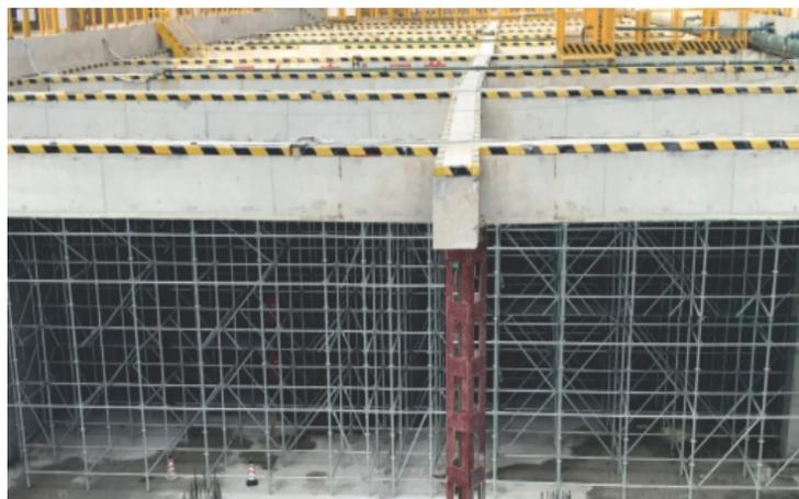
车站顶板盘扣式脚手架应用
