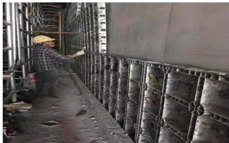
车站侧墙塑钢模板拆除
